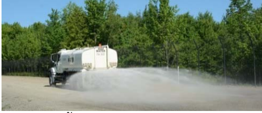
ฉีดพรมน้ำตลอดเส้นทางขนส่งแร่
