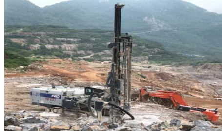
เจาะระเบิดแบบดินตะขาบที่มีเครื่องดักฝุ่น
